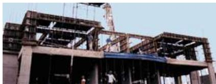
Estrutura reticulada de concreto armado
