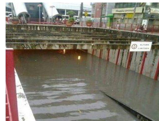
Túnel Via Mangue – 1ª Etapa
