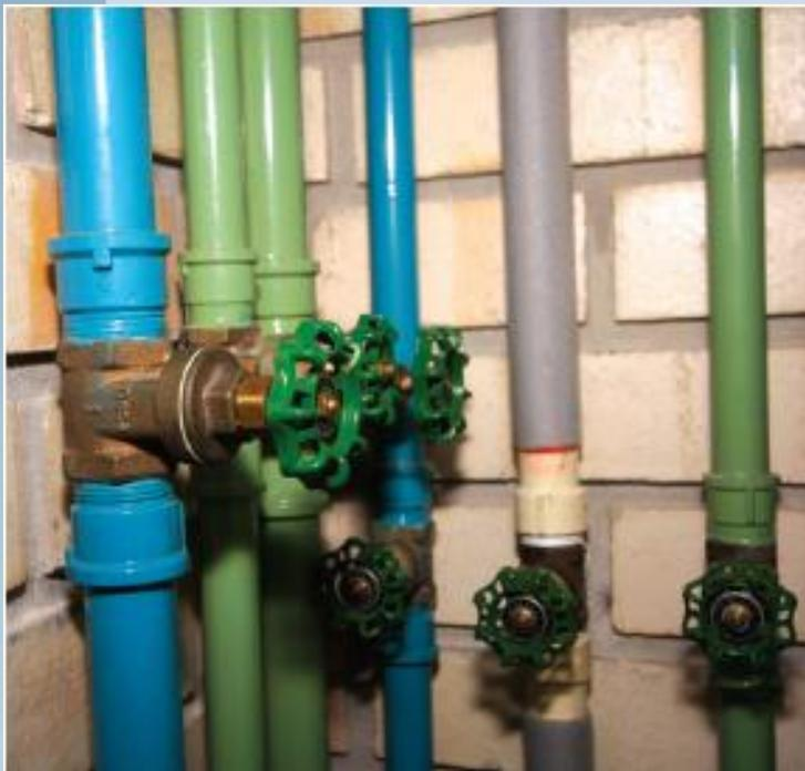
Tubulação aparente com identificação por cores distintas para cada tipo de água (água potável, água de chuva, águas cinzas).
